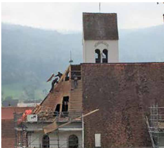
Dachsanierung in luftiger Höhe oberhalb des Chors der Kirche in Hofstetten
