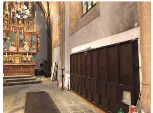
Das Innenleben des neuen Chorgestühls: Heizung für die kalten Tage
