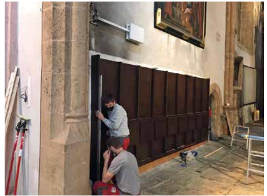
Montage des neuen Chorgestühls mit Klappsitzen
