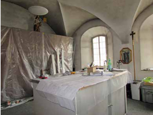
Die Sakristei wird zum Stau- und Lagerraum.
